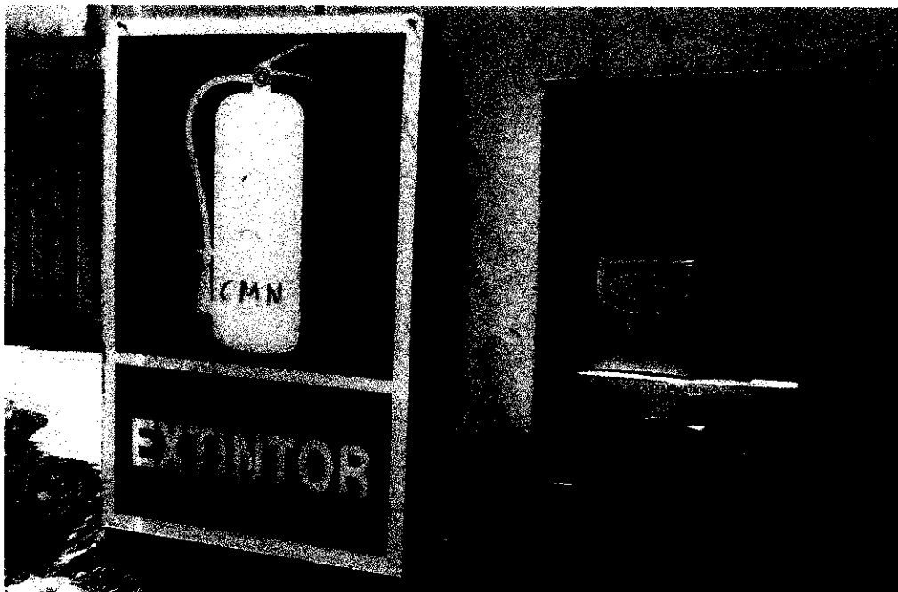
EXTINTOR EN SECTOR A1
